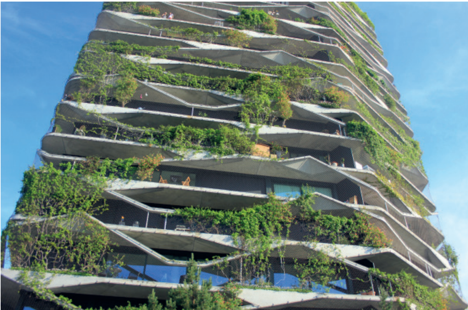
Kletterhilfen und Pflanzkästen auf verschiedenen Ebenen ermöglichen begrünte Fassaden sogar an Hochhäusern wie dem «Garden Tower» in Wabern (BE). Dies ergibt eine Verbindung vom Boden bis in Dachhöhe. Foto: Livio Rey
