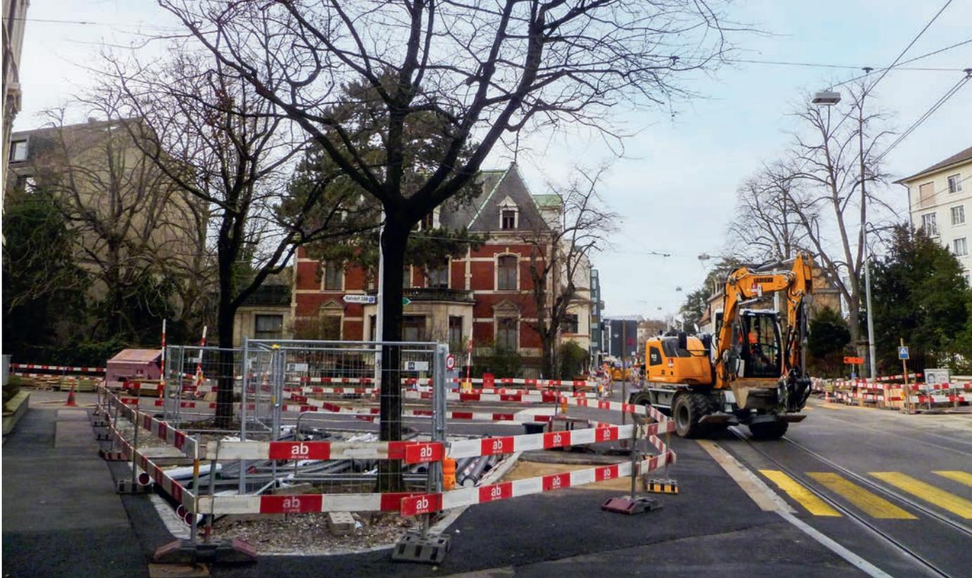
Die Bäume wurden weiträumig abgesperrt, sodass auch von den rangierenden Baumaschinen keine Verletzungsgefahr für Stamm und Krone besteht.
