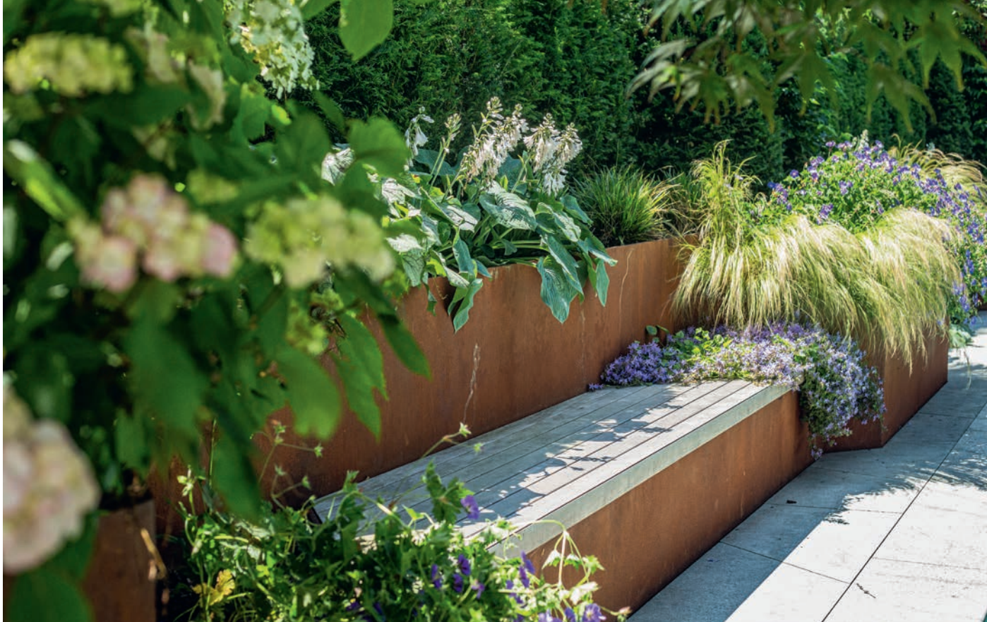
Diese begrünte und abgestufte Grundstücksabgrenzung aus 15 Millimeter starkem Stahl ist sandgestrahlt und wurde vorgerostet eingebaut. Speziell gefertigte Sitzauflagen laden zum Verweilen ein. Foto: LSLA GmbH
