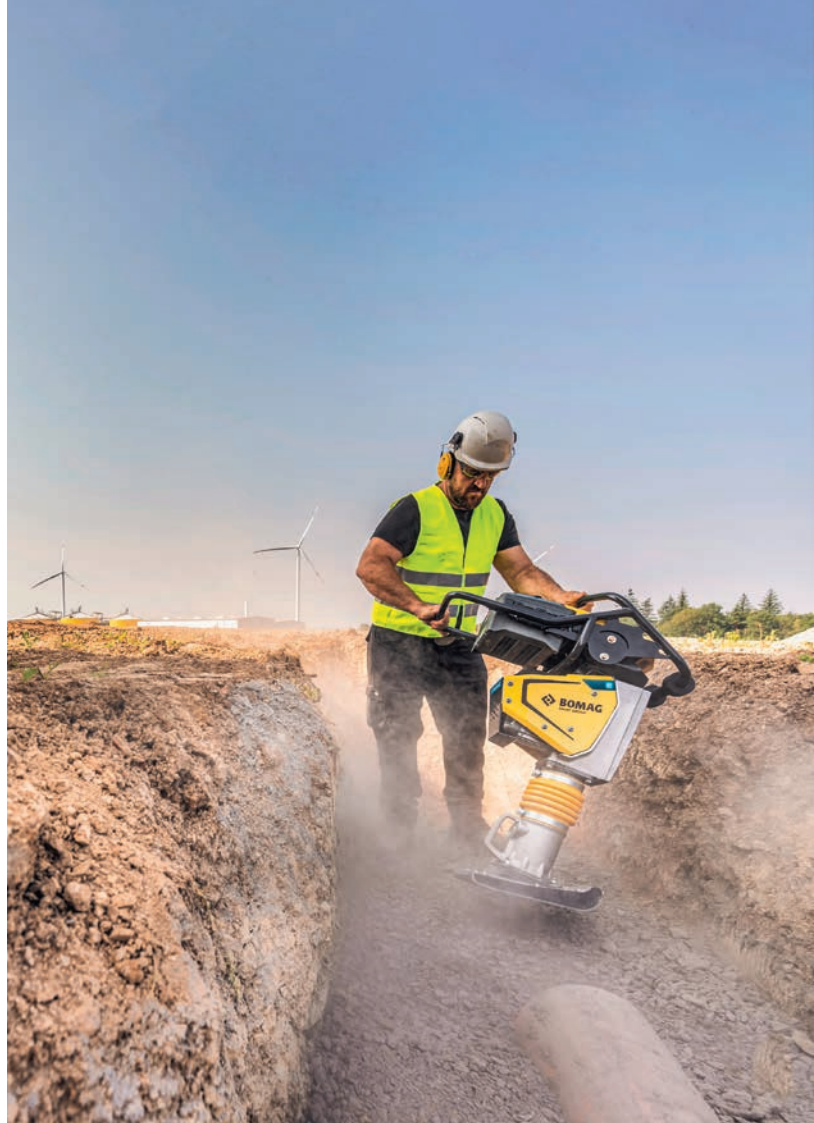
Dass die Zukunft der leichten Verdichtung elektrisch wird, zeigt auch der Hersteller Bomag mit seinem Akkustampfer BT 60e für lärmarme, abgasfreie Verdichtung in sensibler Arbeitsumgebung.
