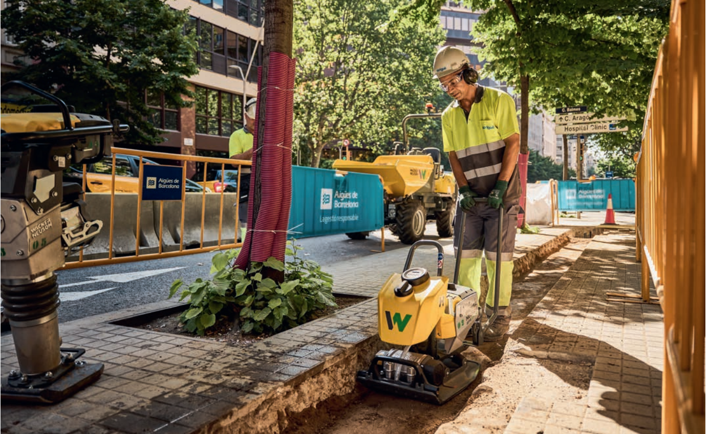
Beim Städteinsatz leichter Verdichter – hier die Rüttelplatte APS 1340e von Wacker Neuson – zeigen alle Pfeile in Richtung Elektroantrieb für ein Minimum an Lärm- und Abgasemissionen.
