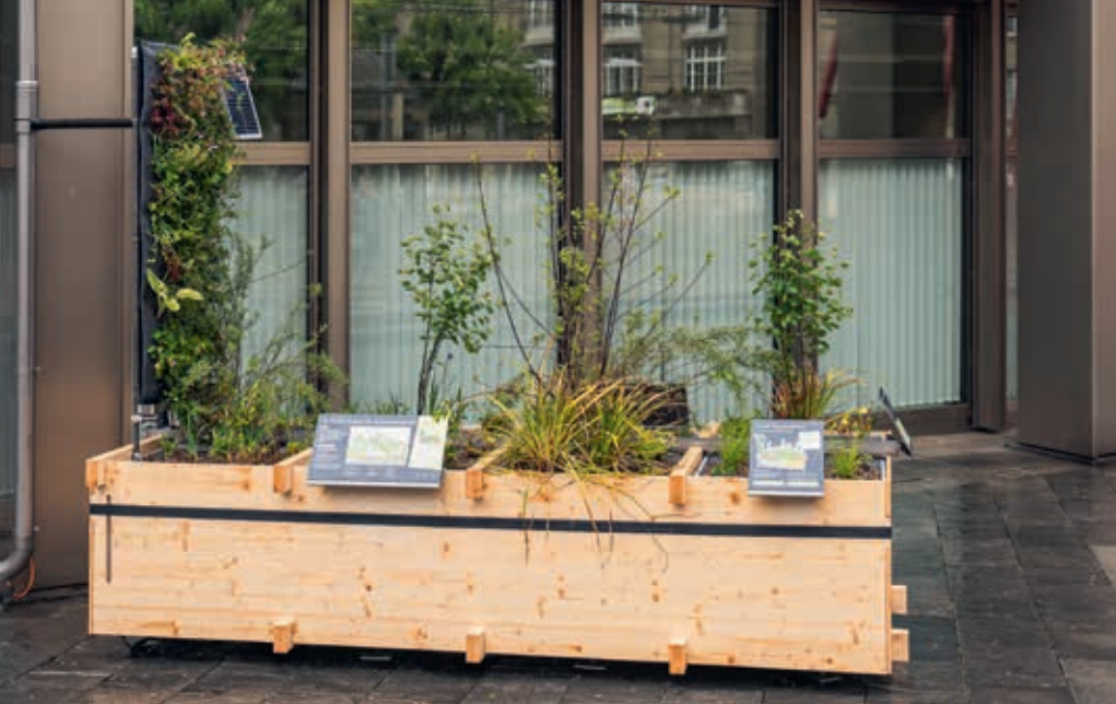
Die Pocket-Schwammstadt zeigt Schwammstadt-Prozesse auf kleinster Fläche. Das Regenwasser gelangt aus einer nahen Dachfläche über das Fallrohr in den Speicher. Eine solarbetriebene Pumpe bewässert regelmässig die Vertikalbegrünung und die Pflanztröge. Dank der Wasserreserve ist ein üppiges Pflanzenwachstum möglich, was Schatten und Kühlung durch Verdunstung ermöglicht. Die bepflanzten Kisten, die Behälter für die Wasserspeicherung, der steckbare Rahmen und das Vertikalbeet sind in Modulbauweise zusammengefügt. Informationstafeln vermitteln alles Wissenswerte zum Prinzip Schwammstadt. Foto: Mobiliar
