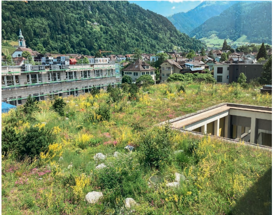
Gründächer in dicht gebauten Quartieren schützen vor Überhitzung. Foto: Paul Siecher
