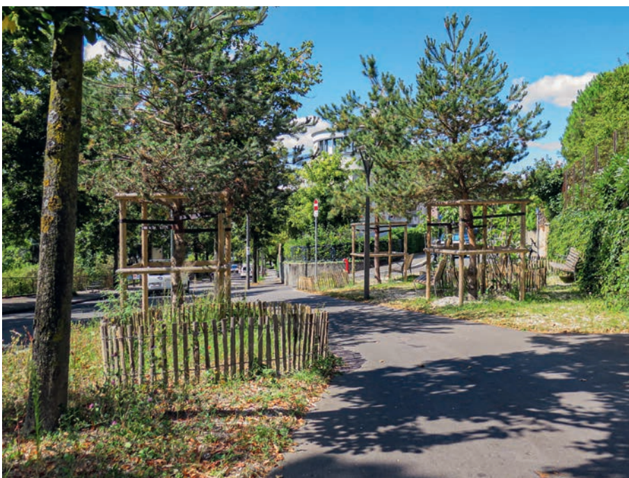
Unten: An der Avenue de Montoie in Lausanne kann Regenwasser in grosszügigen Grünflächen versickern. Foto: Approches SA
